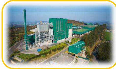
Adaptación instalaciones/ nuevas recogidas
